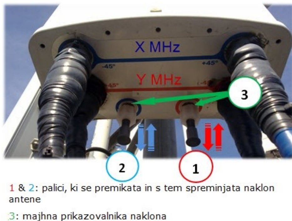
Slika 11: Dvojna antena (dva frekvenčna posova), ki ji je mogoče spreminjati naklon (RET-antena) [5]
