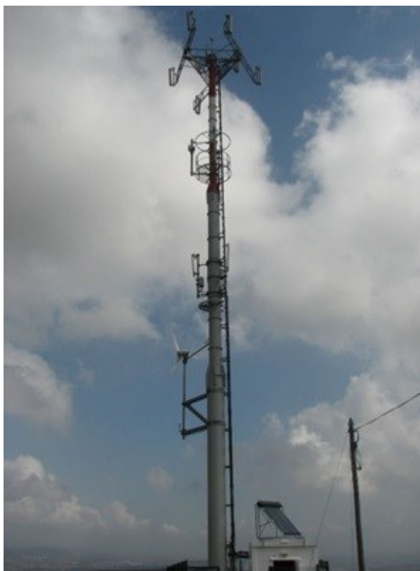
Slika 10: Bazna postaja, ki uporablja energijo vetra in sonca kot obnovljiv vir energije [4]
